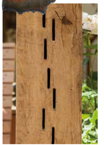
Vlinderkolom - vlindernest-openingen in houten kolom
